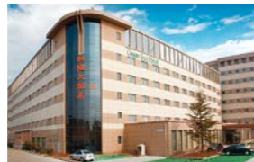
Nidec Total Service (Zhejiang) Corp. Green Sun Hotel 日本電産総合サービス(浙江)有限公司 緑園大飯店(ホテル)
